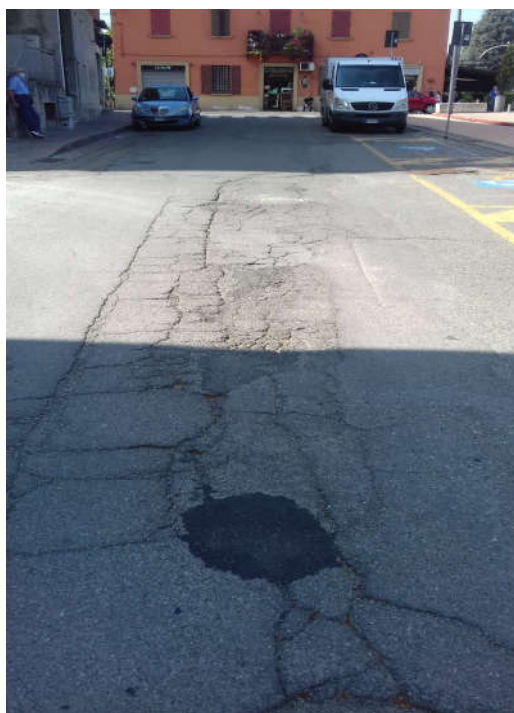
Tipologia di pavimentazione ammalorata superficialmente
