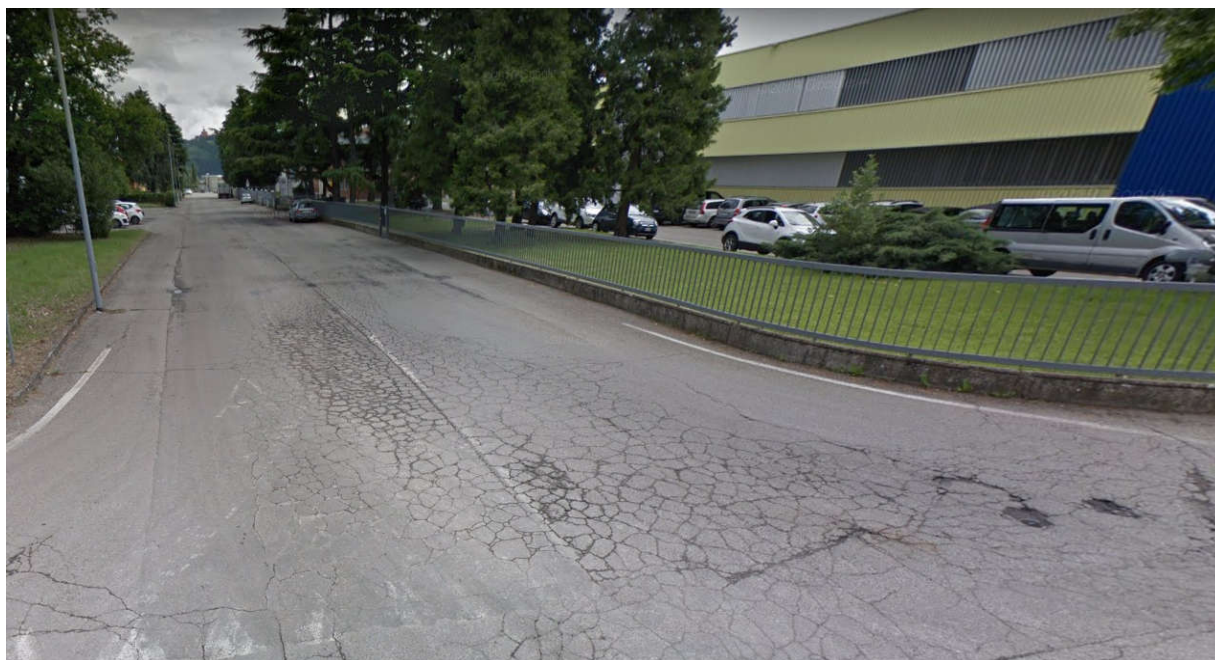
Tipologia di ammaloramento che interessa gli strati del pacchetto di fondazione
