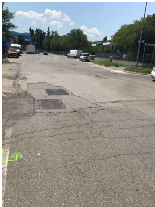
Tipologia di pavimentazione ammalorata superficialmente
